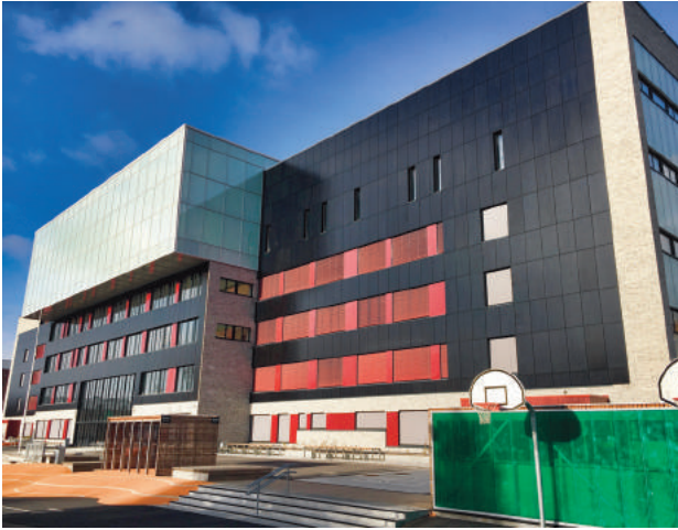
Figur 7.2 Bygningsintegrert solcelleanlegg på Brynseng Skole i Oslo. Foto: Lisa Kvalbein, IFE.
