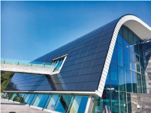
Figur 7.3 Bygningsintegrert solcelleanlegg på Oseana i Osøyri. Foto: Lisa Kvalbein, IFE.
