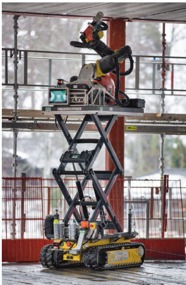
Figur 17.2 Borerobot som lager hull i tak i nybygg. Foto: nLink.
